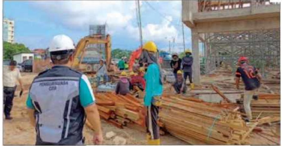
PEMERIKSAAN di tapak pembinaan di Jalan Sin Onn.
