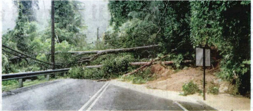
TANAH runtuh yang membawa pokok hutan menyebabkan laluan utama menuju Wang Kelian dan View Point ditutup sepenuhnya kerana mengancam keselamatan pengguna.
